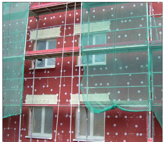
Fassade mit WDVS
